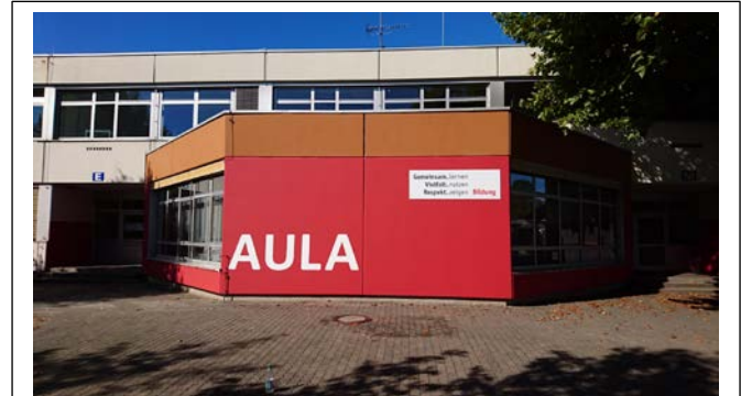
Die Aula der GHS nach dem Anstrich
