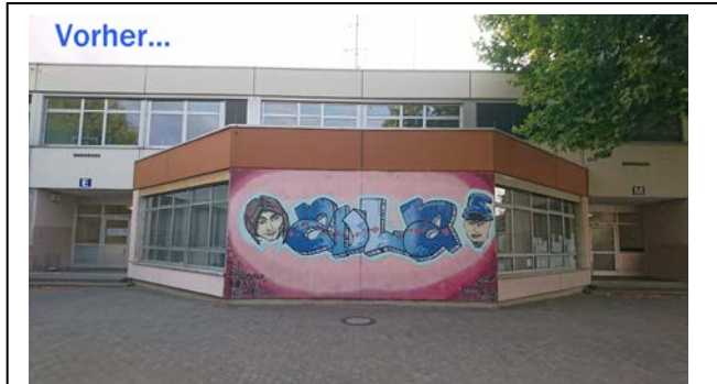
Die Aula der GHS vor dem Anstrich
